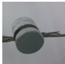
图 4.17 线线连接器安装效果
